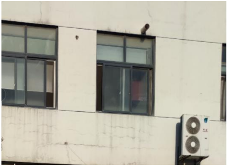
通风换气系统
