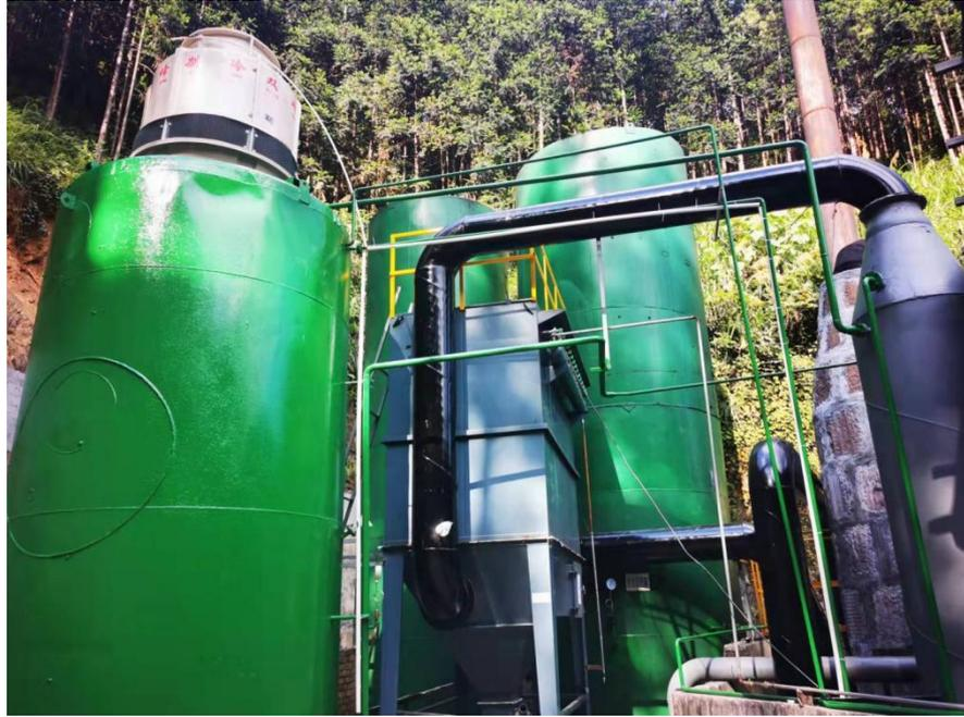
图 6-3 锅炉碱喷淋+水膜除尘设施照片
