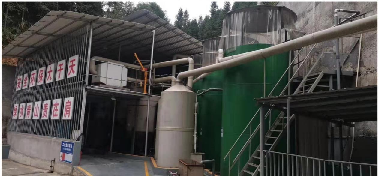
图 6-4 污水处理站碱喷淋+UV 光解+碱喷淋处理设施照片
