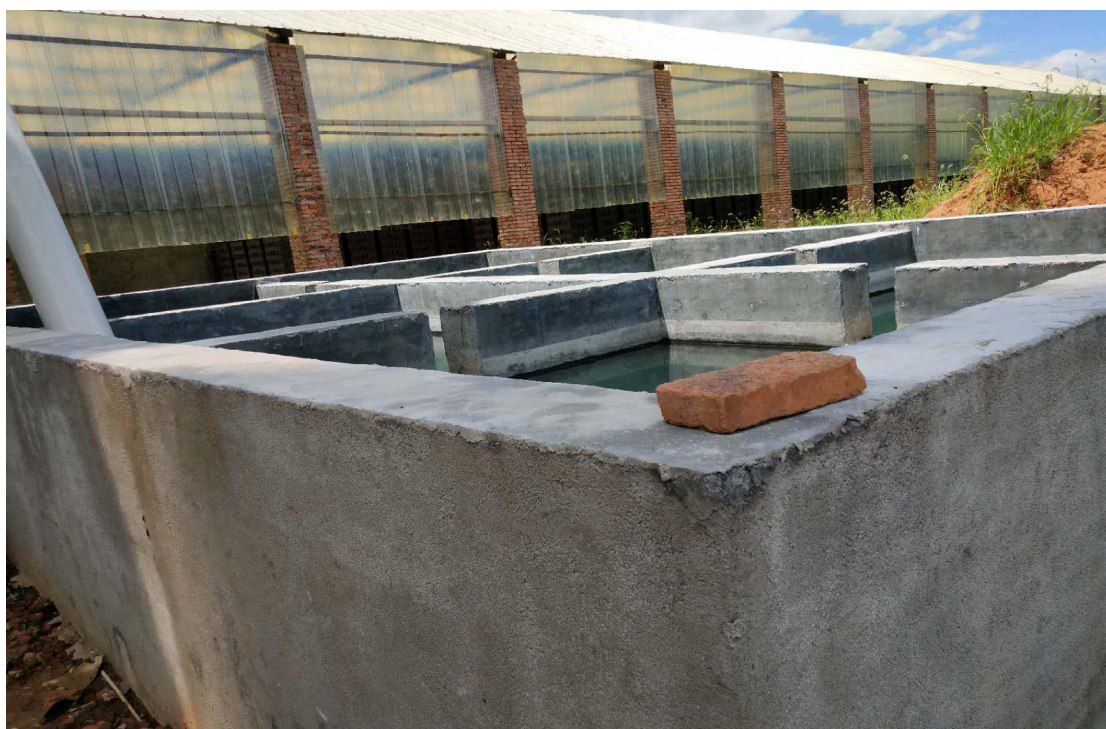
图 4-3 脱硫塔循环水池
